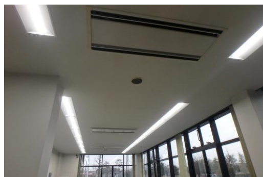
▲交換したLED照明
